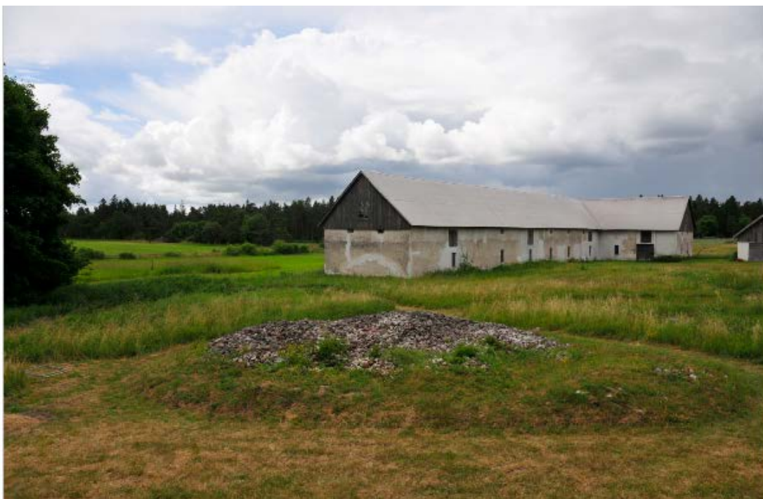
Fig. B1:1. Schakt 12 och schakt 7 innan utgrävning, foto mot S. Foto: Arkeologisk undersökning vid Buttle Änge 2013
